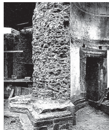
Rara immagine di particolari interni originali della Rotonda del Brunelleschi prima dei lavori di restauro.
