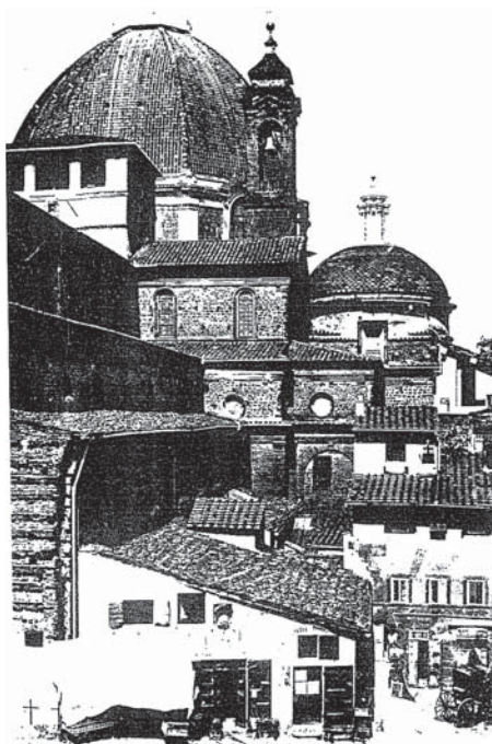
Antica veduta dell'esterno di S. Lorenzo con le case addossate lungo il lato settentrionale.
