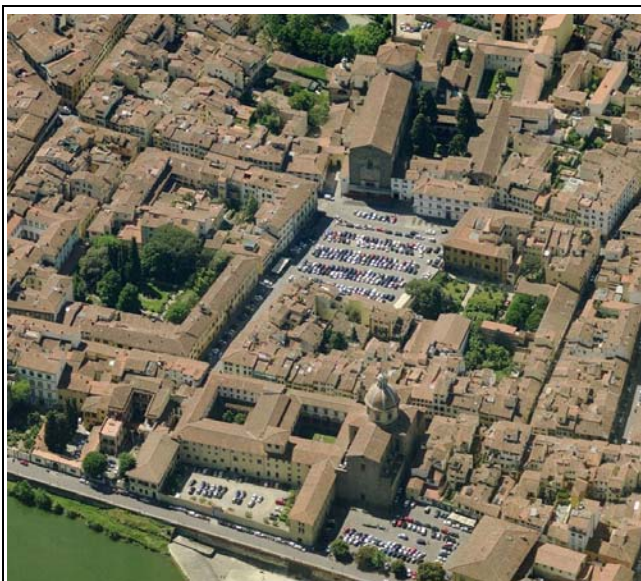
Vista aerea ante operam
